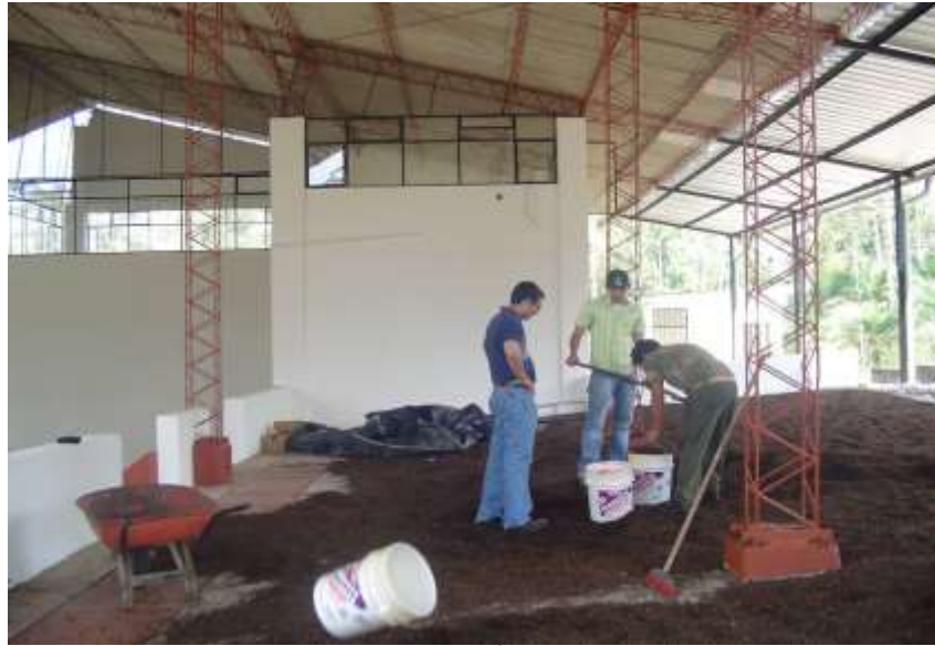
Fotografía # 5. Área de acopio
