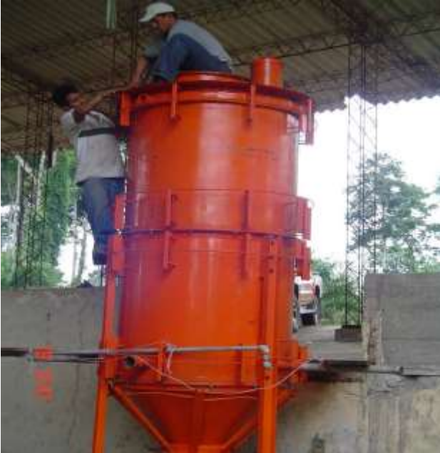
Fotografía # 8. Retorta en construcción
